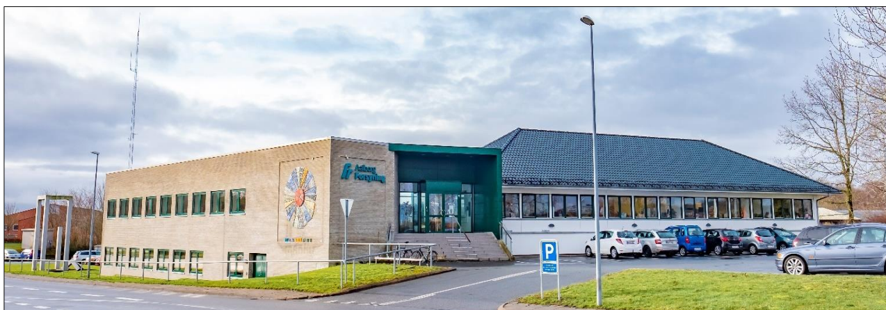
Foto: Hovedadressen for Aalborg Renovation, Over Bækken 2
