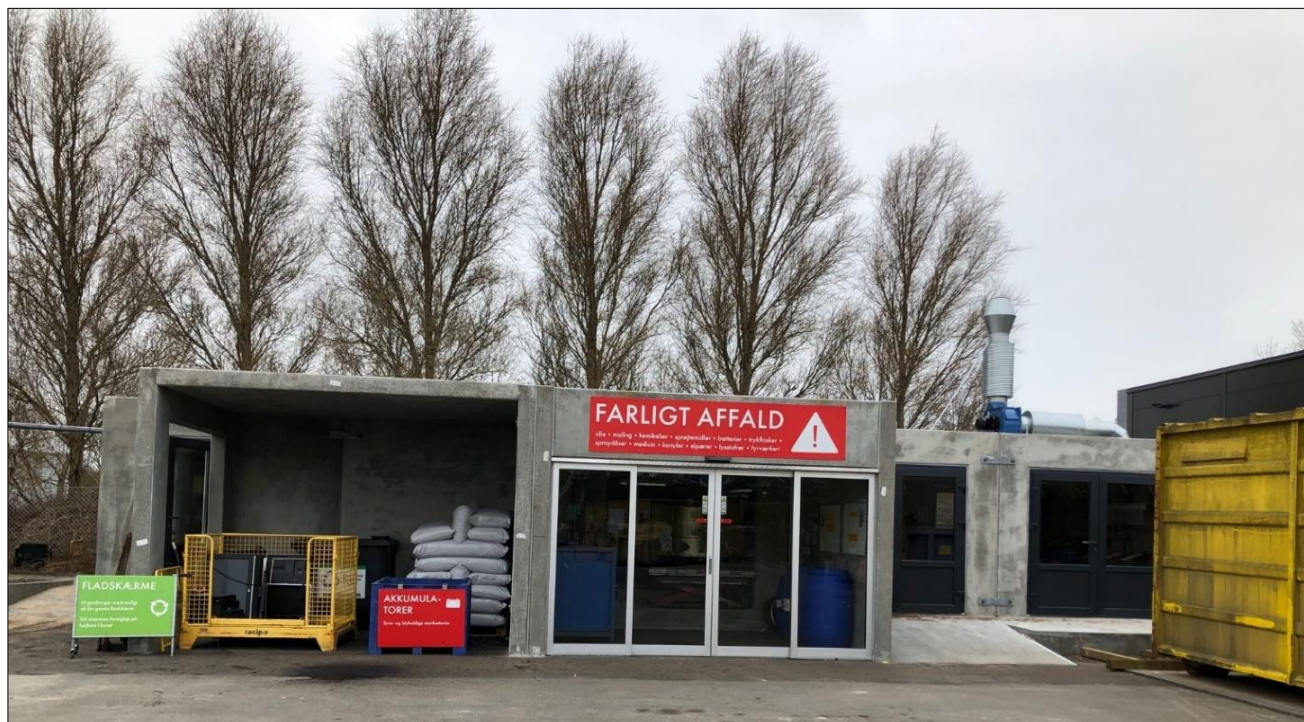
Foto: Bygning til farligt affald på Genbrugspladsen Over Kæret
